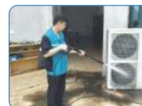
Mycie jednostek zewnętrznych
